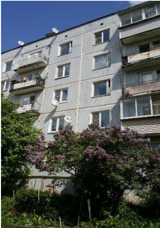
Фотография 10.1. Фасад здания, позволяющий судить об этажности
